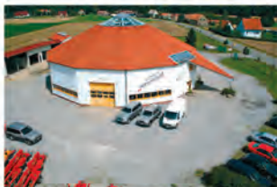
Lift-Manager Zentrale Jänkendorf
